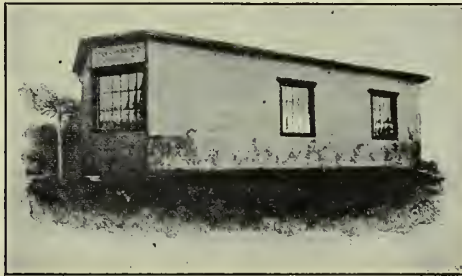
Böcklins Atelier in Zürich, welches er sich selbst hatte bauen lassen.
